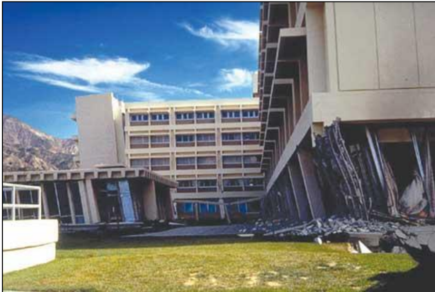
1971 San Fernando, California 5-όροφο Νοσοκομείο Olive View
