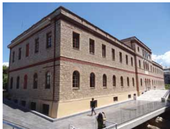
Πιλοτική εφαρμογή της μεθόδου Δευτεροβάθμιου Προσεισμικού Ελέγχου για κτίρια από τοιχοποιία στο Κτίριο Weiler (Μακρυγιάννην 2-4, Ακρόπολη)
