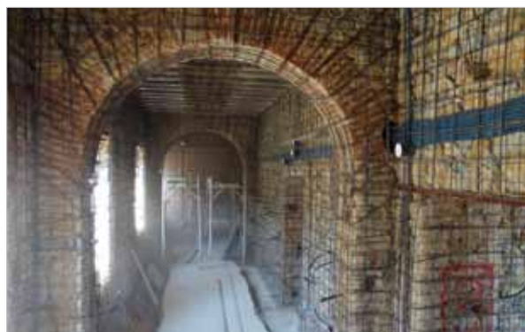
Ενίσχυση κτιρίου από φέρουσα τοικοποιία
