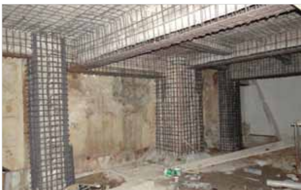
Ενίσχυση κτιρίου από οπλισμένο σκυρόδεμα
