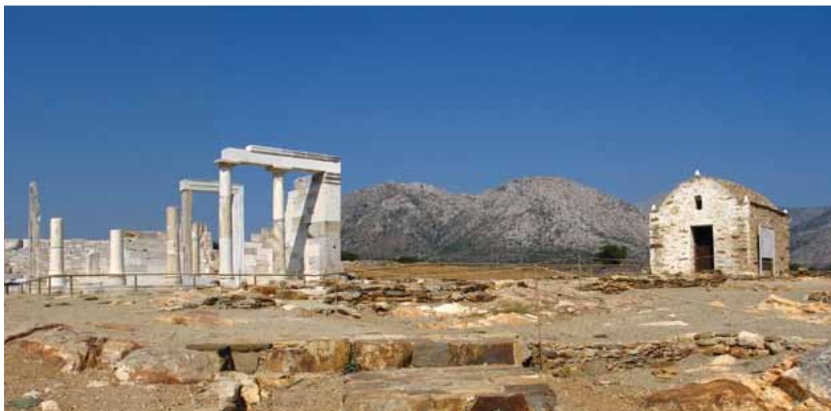
Μνημεία που αντιστοιχούν στους υπό εξέταση δομικούς τύπους της δράσης «Pre-Earthquake assessment of Monuments, comparison of analytical methodologies» (Πηγή: Παραδοτέο Ο. Μ. της δράσης για τον Προσεισμικό Έλεγχο των Μνημείων του Ε.Κ.Π.Π.Σ.)
