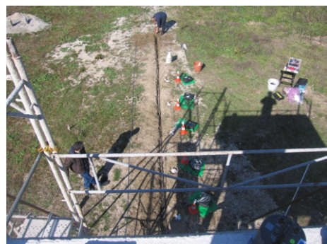
Ενοργάνωση εδάφους θεμελίωσης με σεισμογράφους CMG-5TD
