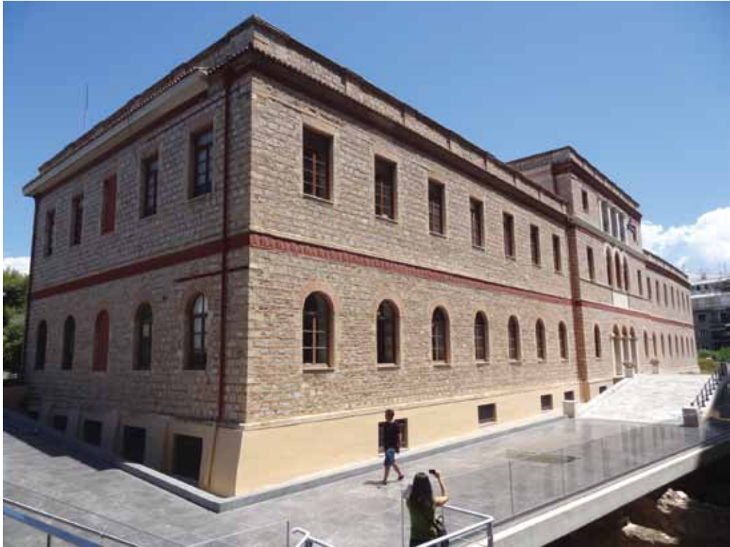
Πιλοτική εφαρμογή της μεθόδου Δευτεροβάθμιου Προσεισμικού Ελέγχου για κτίρια από τοιχοποιία στο Κτίριο Weiler (Μακρυγιάννη 2-4, Ακρόπολη)
