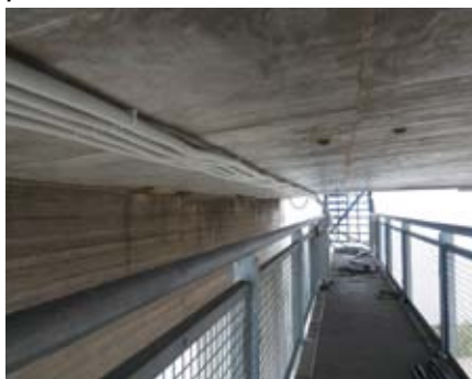
Εικόνα 21. (α) Νέα κεντρική καταγραφική μονάδα και (β) καλώδια επέκτασης από νότια σε βόρεια πλευρά Ευβοϊκού Πυλώνα
