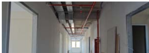
Εικόνα 27. Πρόσφατη αποτύπωση της προόδου κατασκευής του έργου:Κτίριο Ο.Α.Σ.Π.-Ι.Τ.Σ.Α.Κ. (Δεκέμβριος 2012)
