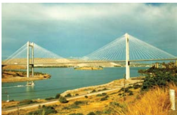
Εικόνα 19. Η υψηλή καλωδιωτή γέφυρα του Ευρίπου
