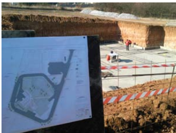
Εικόνα 26. Εργοτάξιο κτιρίου Ο.Α.Σ.Π.-Ι.Τ.Σ.Α.Κ.
