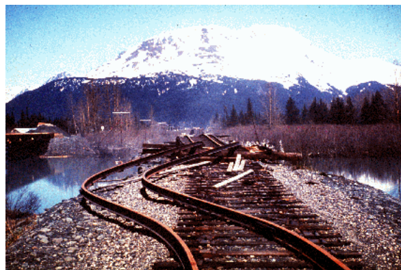
Εικ. 2.5. Βλάβες στο σιδηροδρομικό δίκτυο (σεισμός Αλάσκας 1964)
