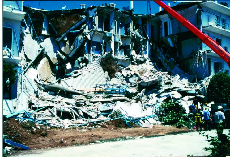
Εικ 4.3. Αίγιο, σεισμός 1995. Κατάρρευση ξενοδοχείου
