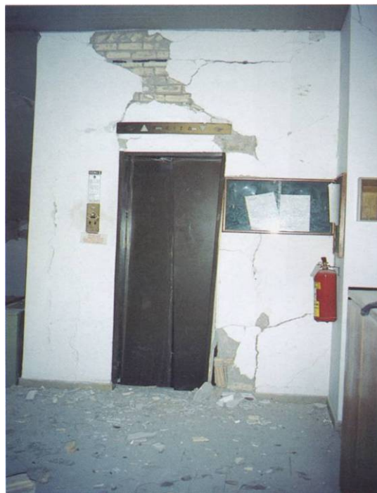
Εικ 3.14. Αίγιο, σεισμός 1995. Ο ανελκυστήρας είχε πάθει βλάβες. Η χρήση του μπορούσε να προκαλέσει τον εγκλωβισμό απόμων.
