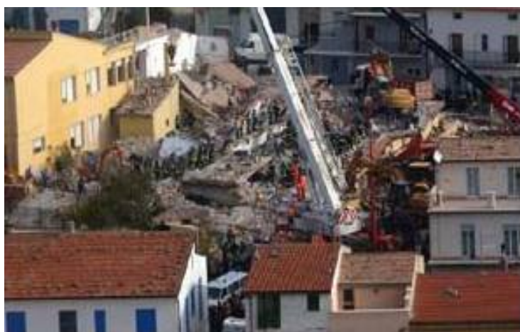
Εικ. 4.8. Βλάβες σε κτίρια στο σεισμό που έπληξε την Ιταλία το 2002
