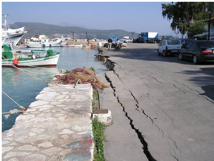
Εικ 3.13α. Λευκάδα, σεισμός 2003. Ο σεισμός προκάλεσε πολλές βλάβες σε λιμάνια και μαρίνες του νησιού
