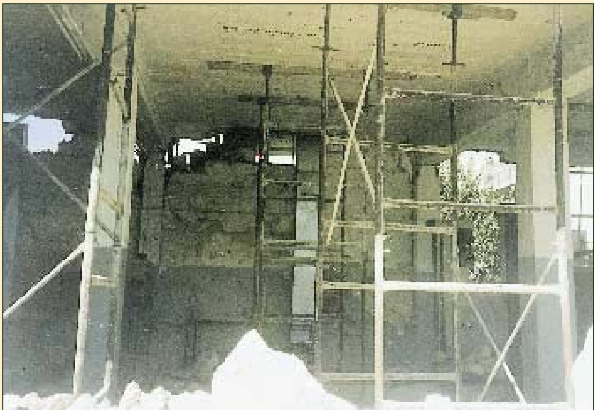
ΑΤΤΙΚΗ - ΜΕΝΙΔΙ- 1999 Μερική υποστύλωση με μεταλλικά βιομηχανικά ικριώματα σε μαλακό όροφο με ελαφρές βλάβες.
