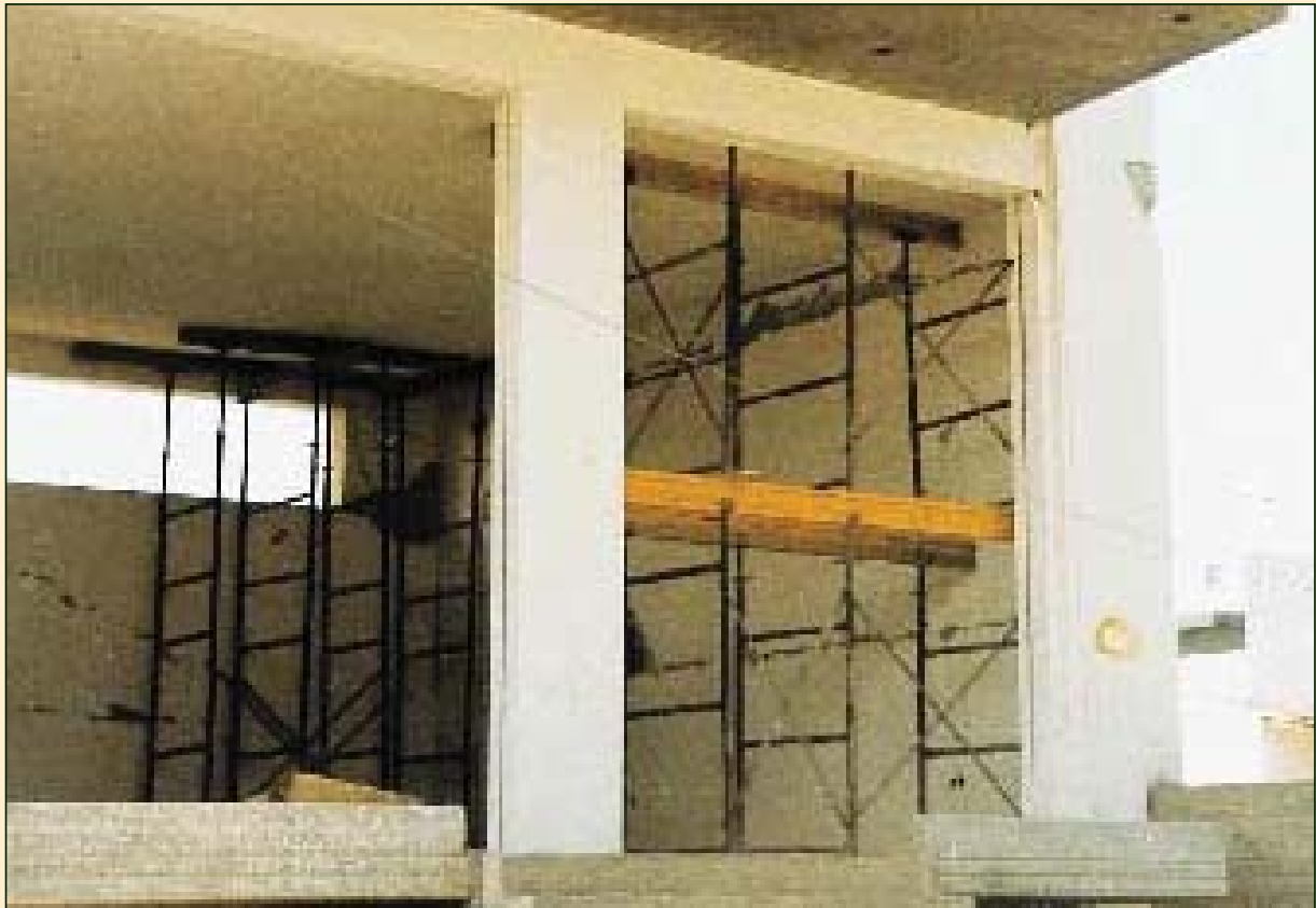
ΑΤΤΙΚΗ - ΜΕΝΙΔΙ- 1999 Μερική υποστύλωση με μεταλλικά βιομηχανικά ικριώματα σε μαλακό όροφο με ελαφρές βλάβες.
