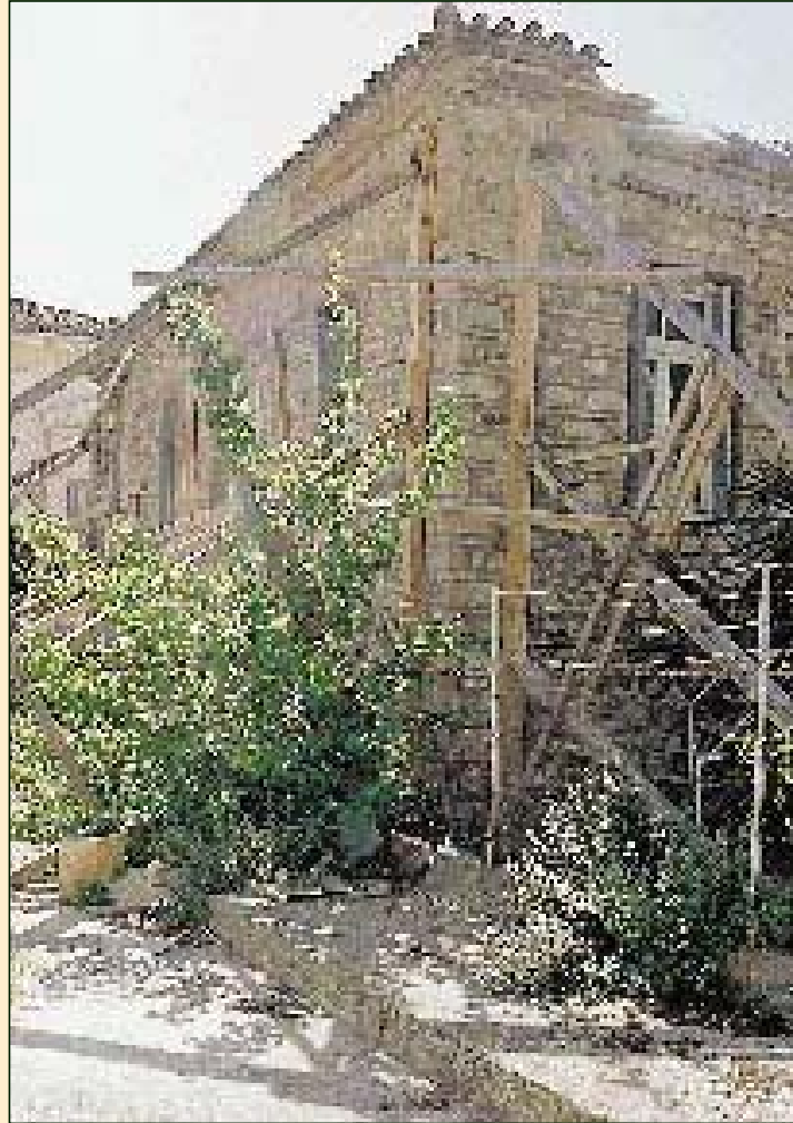
ΑΙΓΙΟ 1995 Αντιστήριξη με βιομηχανική ξυλεία σε διόροφη λιθόκτιστη οικοδομή.
