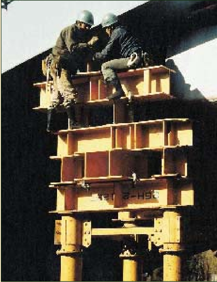
ΚΟΜΠΕ Ιαπωνίας 1995 Εκτεταμένες και βαριές υποστυλώ- σεις με «πάσης φύσεως» σιδηρές δια- τομές, βαρέως τύπου σε μεγάλες γέφυρες της πόλης, που υπέστησαν σοβαρές βλάβες στα βάθρα τους και σε μήκος πολλών χιλιομέτρων.
