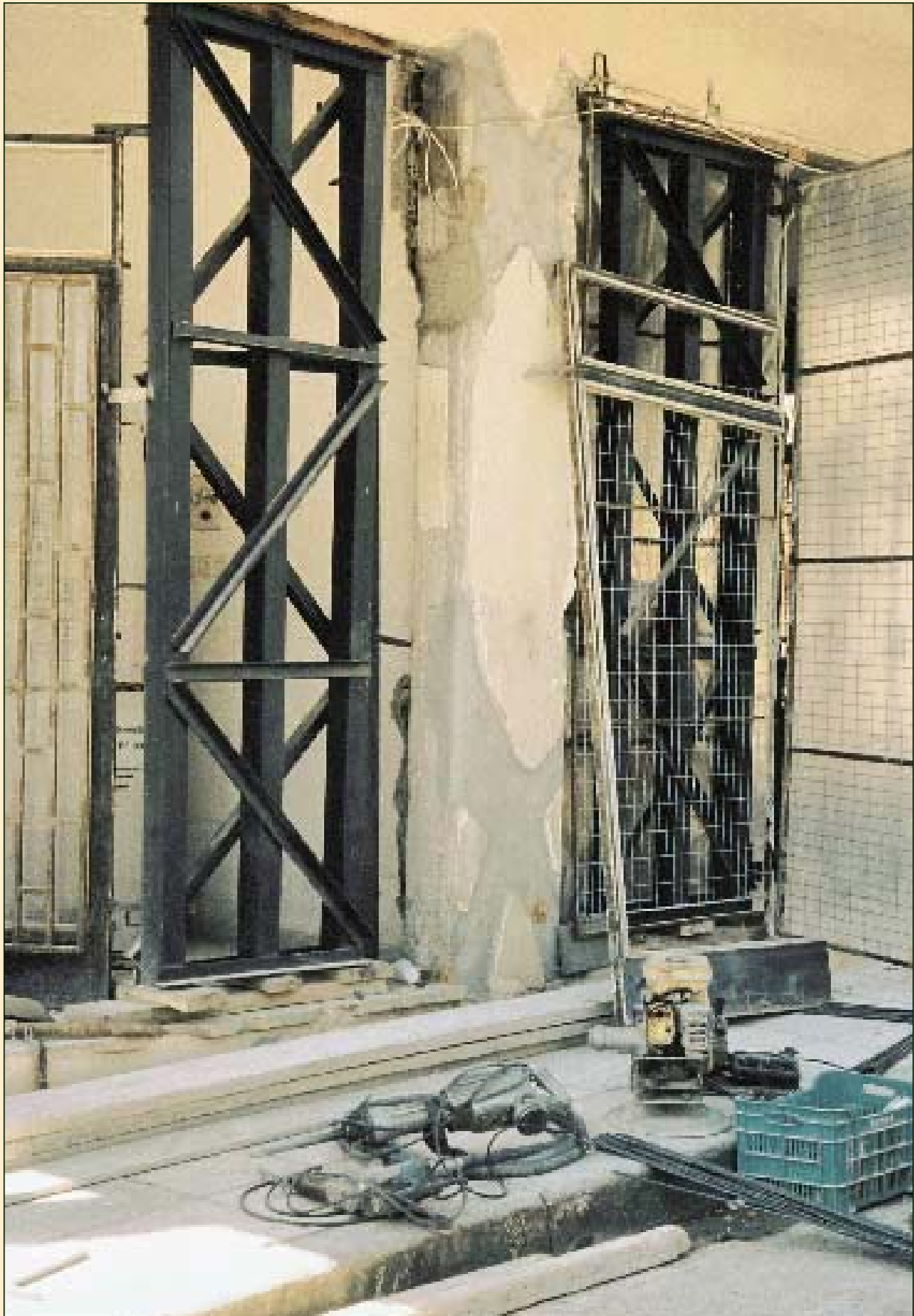
ΑΪΓΙΟ 1995 Υποσύλωση με τετράγωνες κοιλοδοκούς εκατέρωθεν βλαμμένου υποστυλώματος. Η μέθοδος αυτή υποσύλωσης είχε ευρεία εφαρμογή στο Αίγιο.
