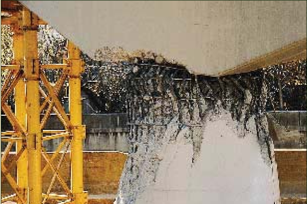
ΚΟΜΠΕ Ιαπωνίας 1995 Εκτεταμένες και βαρείες υποστυλώσεις με «πάσης φύσεως» σιδηρές διατομές, βαρέως τύπου σε μεγάλες γέφυρες της πόλης, που υπέστησαν σοβαρές βλάβες στα βάθρα τους και σε μήκος πολλών χιλιομέτρων.
