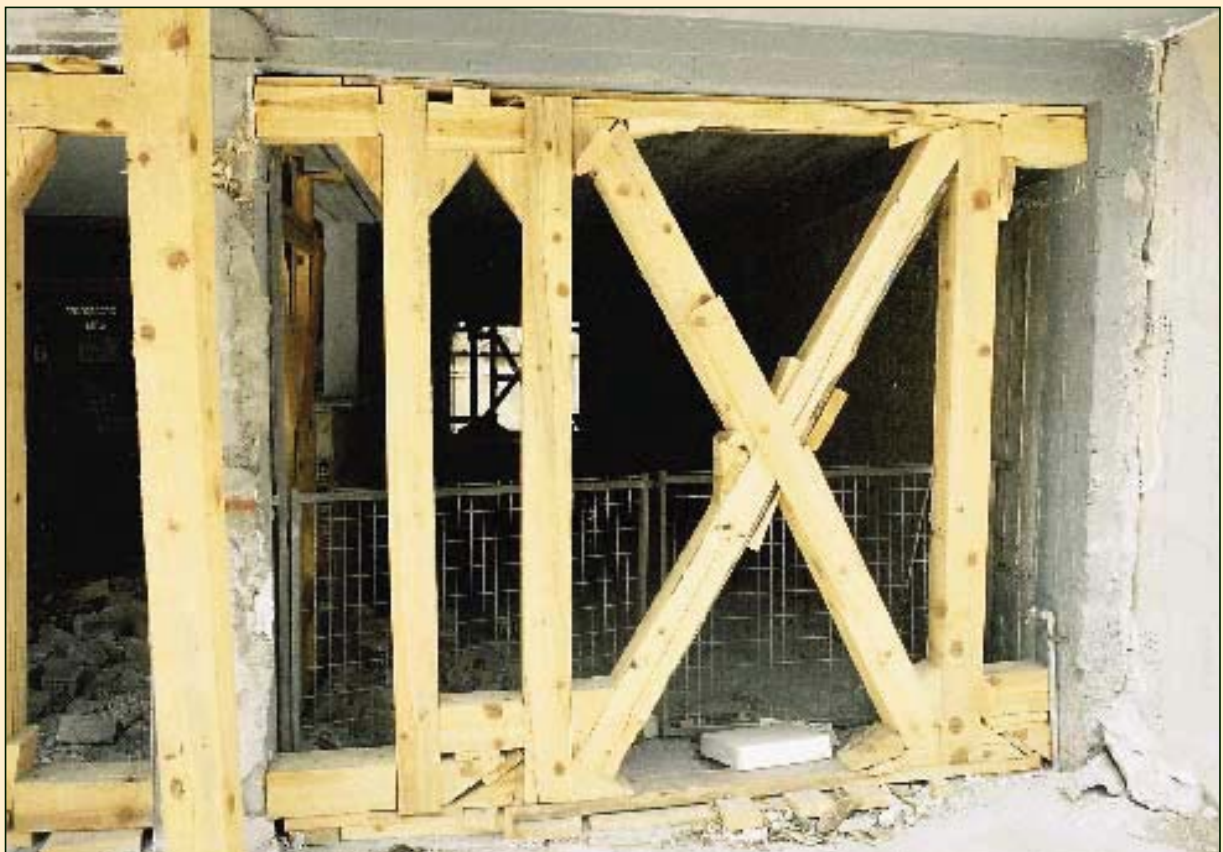
ΚΑΛΑΜΑΤΑ 1986 Υποσιλώσεις - Αντιστηρίξεις με Βιομηχανική Ξυλεία.
