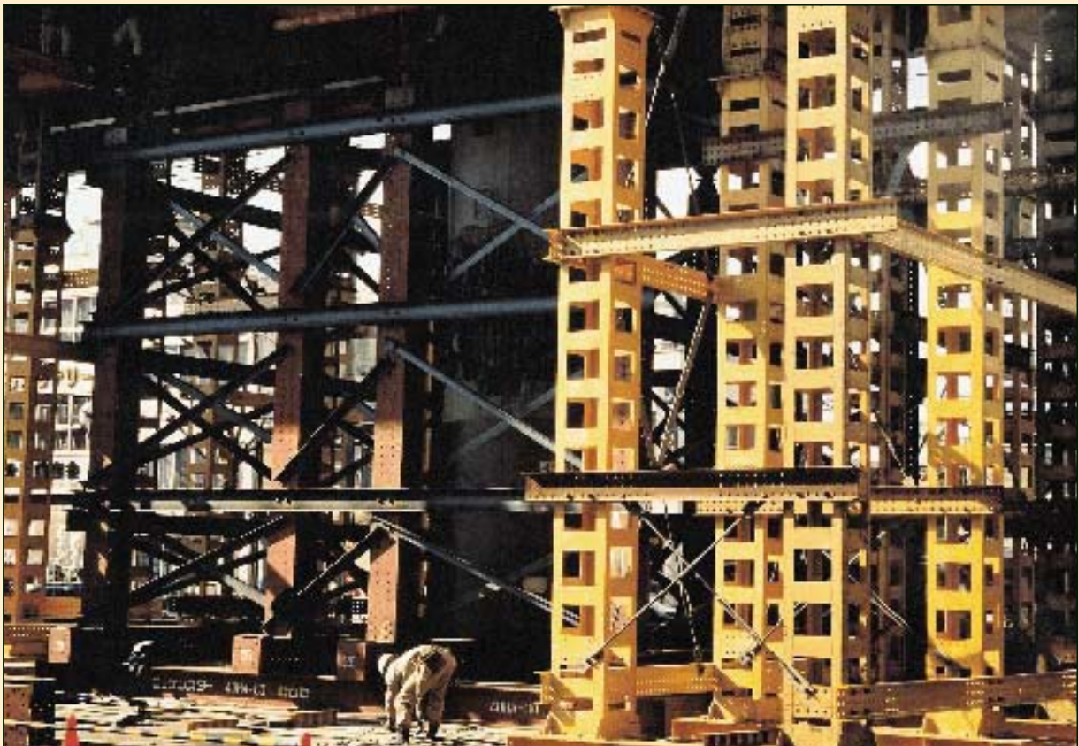
ΚΟΜΠΕ Ιαπωνίας 1995 Εκτεταμένες και βαριές υποστυλώ- σεις με «πάσης φύσεως» σιδηρές δια- τομές, βαρέως τύπου σε μεγάλες γέφυρες της πόλης, που υπέστησαν σοβαρές βλάβες στα βάθρα τους και σε μήκος πολλών χιλιομέτρων.
