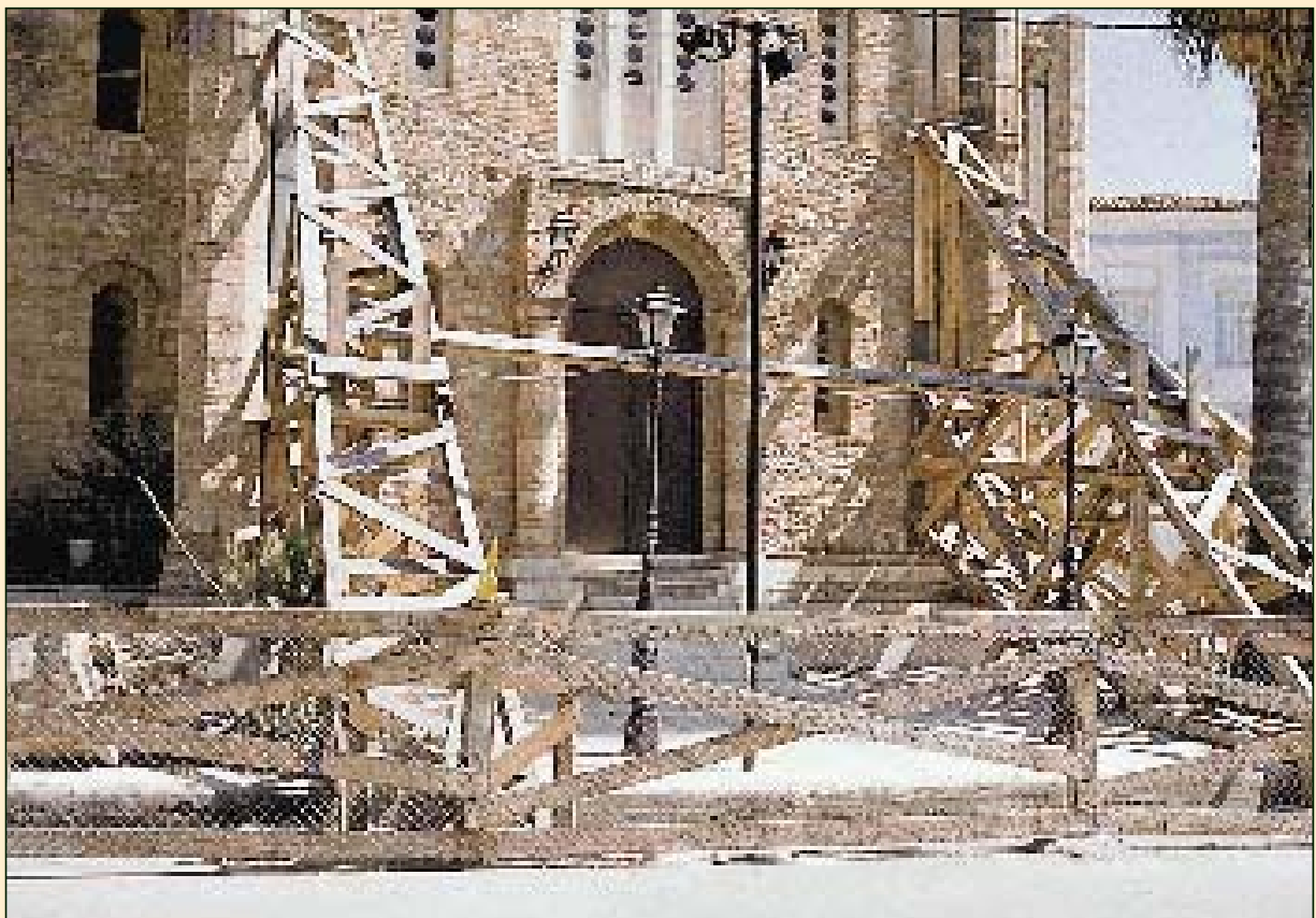
ΑΠΡΙΛΙΟΣ 1995 Εκτεταμένη αντιστήριξη με βιομηχανική ξυλεία στο Ναό Εισοδίων της Θεοτόκου - Έργο Τσίλλερ, - ο οποίος υπέστη σοβαρές βλάβες.
