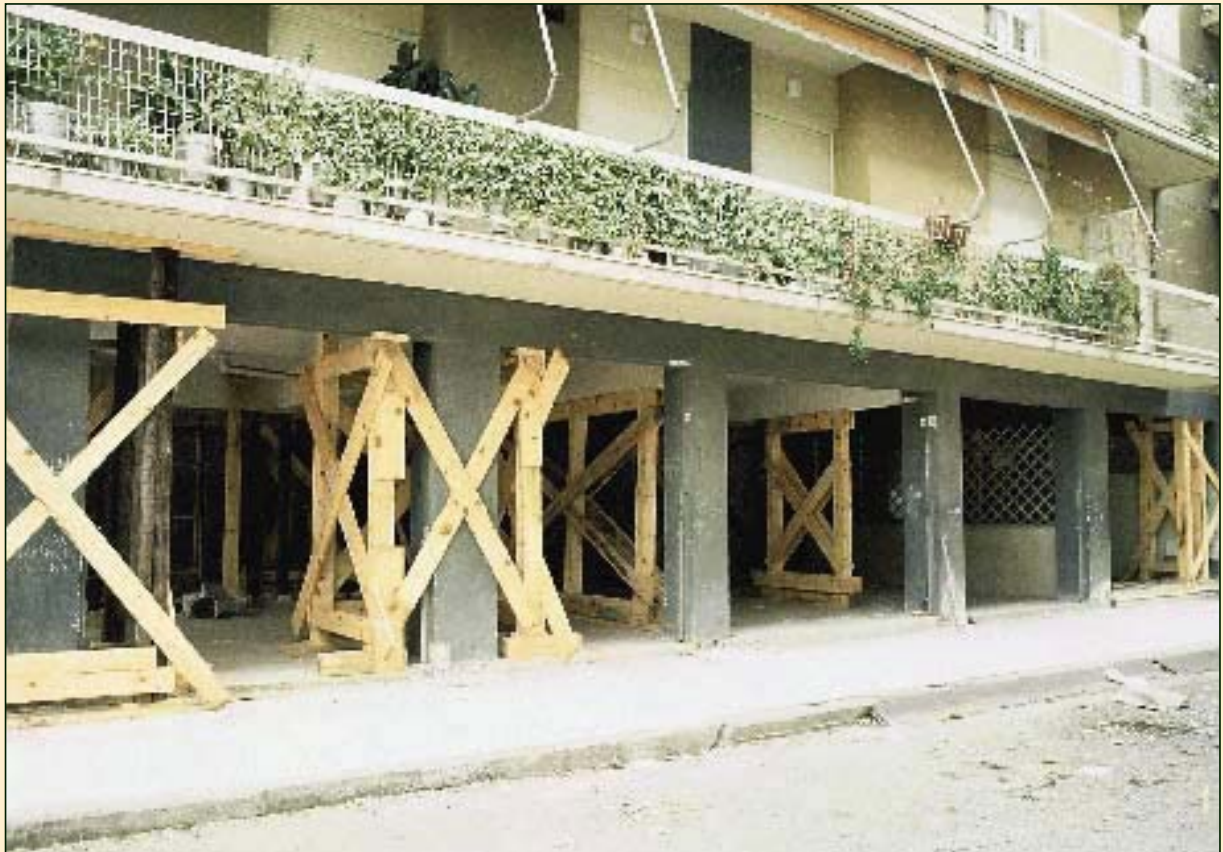
ΚΑΛΑΜΑΤΑ 1986 Υποσιλώσεις - Αντιστηρίξεις με Βιομηχανική Ξυλεία.
