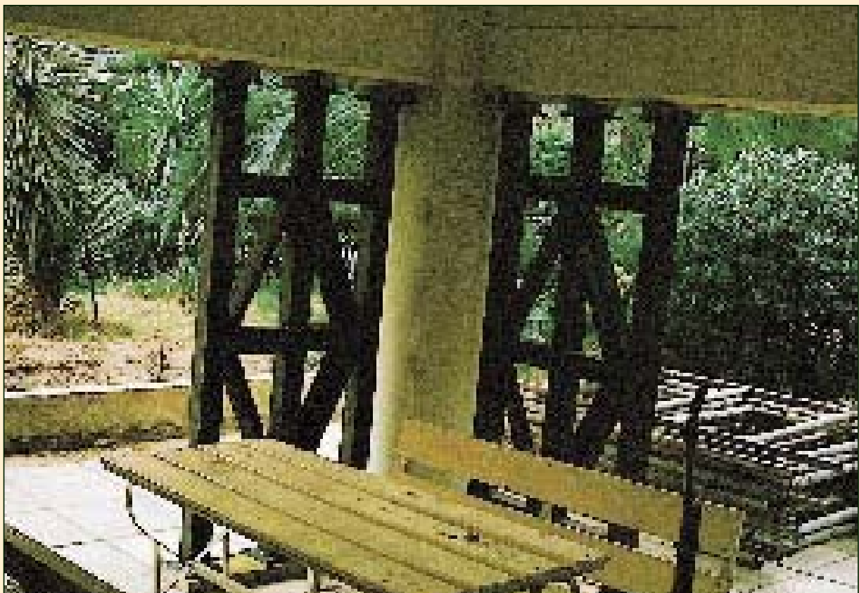
ΑΤΤΙΚΗ - ΝΕΟ ΗΡΑΚΛΕΙΟ - 1999 Εκτεταμένη υποσύλωση με κοιλοδοκούς σε Pilotis εξάρροφης οικοδομής, με σοβαρές βλάβες σε αρκετά από τα υποστυλώματά της
