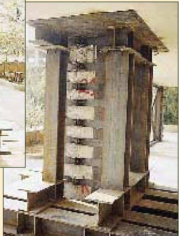
ΜΕΤΑΜΟΡΦΩΣΗ ΑΤΤΙΚΗΣ 1995 Εκτεταμένη υποσύλωση με σιδηρές διατομές (γωνιακά ισχυρά, διπλά ταύ, λάμες, χιαστί συνδέσμους κ.λπ.) σε τετράροφη οικοδομή με σοβαρές βλάβες στα υποστυλώματα της Pilotis
