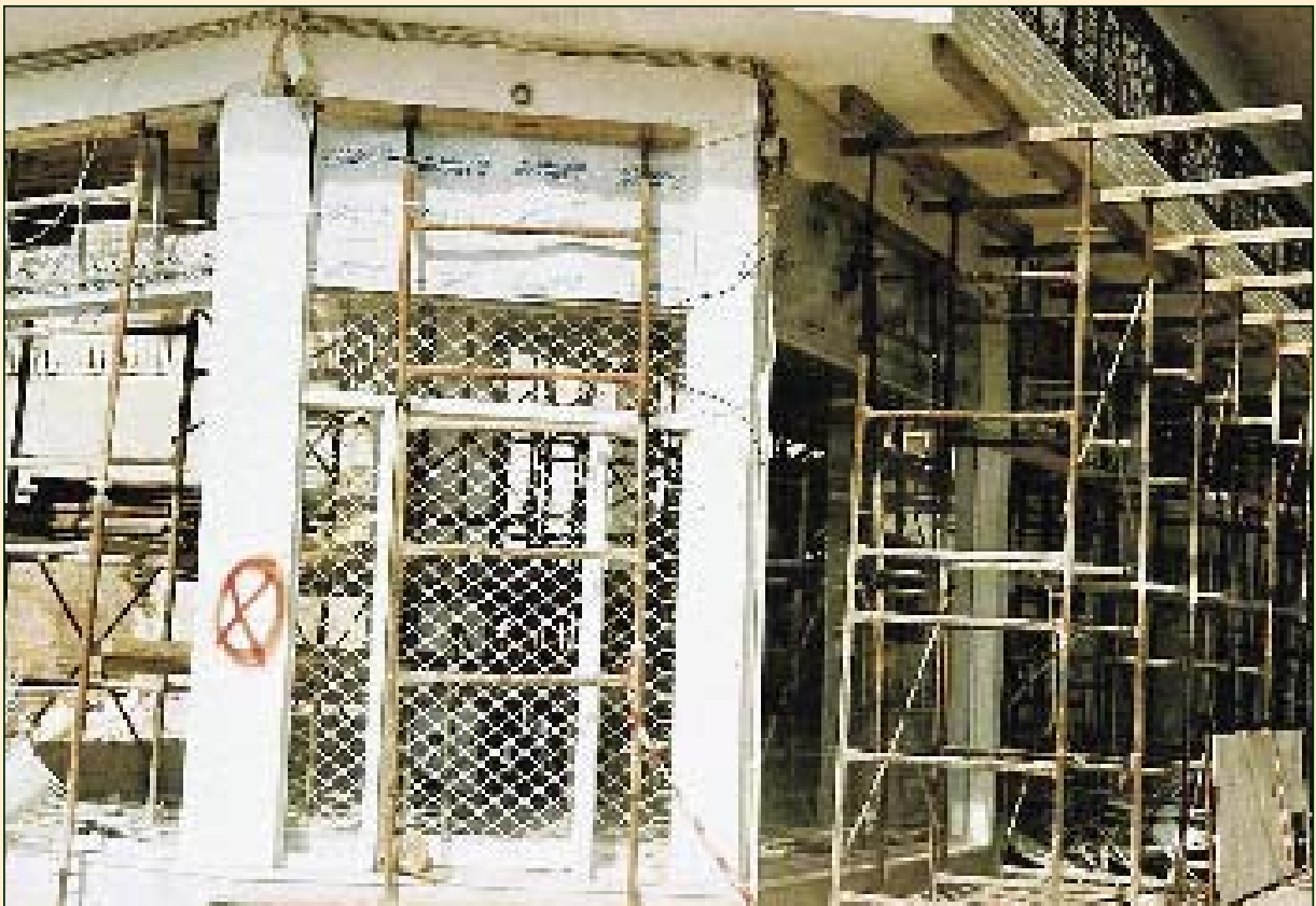
ΑΤΤΙΚΗ - ΑΝΩ ΛΙΟΣΙΑ - 1999 Υποσιλώσεις με βιομηχανικά ικριώματα, των οποίων έγινε ευρεία, αλλά όχι πάντοτε σωστή χρήση, στην περίπτωση του καταστροφικού σεισμού της Αττικής.
