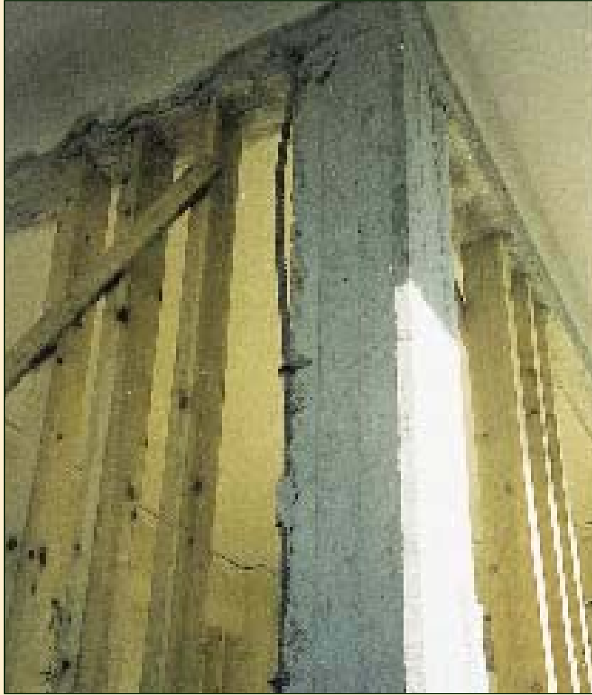
ΑΤΤΙΚΗ - ΑΝΩ ΛΙΟΣΙΑ - 1999 Υποστυλώσεις με βιομηχανική ξυλεία στα πλαίσια μεταξύ υποστυλωμάτων
