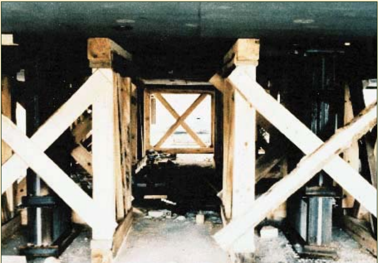
ΚΑΛΑΜΑΤΑ 1986 Υποστυλώσεις - Αντιστηρίξεις με Βιομηχανική Ξυλεία και περίσφιξη με σιδηρά σε όλα τα βλαμμένα υποστυλώματα της Pilotis.
