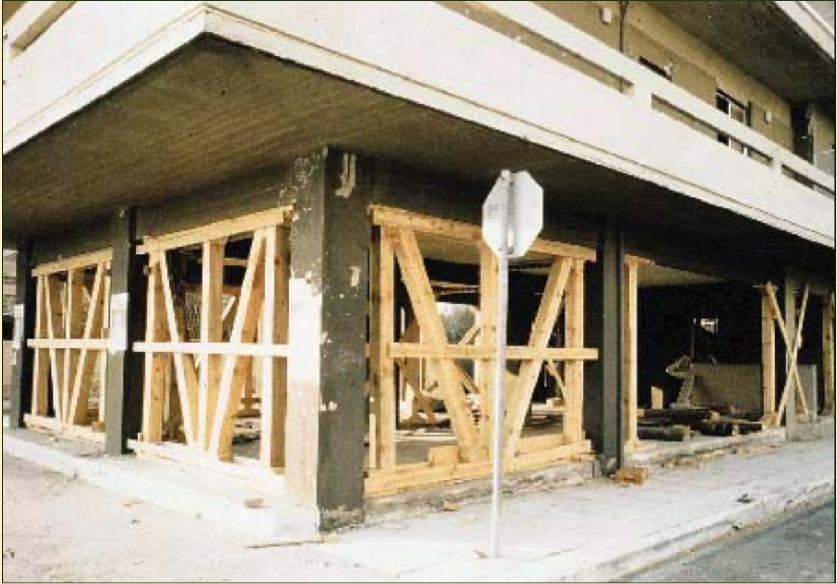
ΚΑΛΑΜΑΤΑ 1986 Υποστυλώσεις - Αντιστηρίξεις με Βιομηχανική Ξυλεία και περίσφιξη με σιδηρά σε όλα τα βλαμμένα υποστυλώματα της Pilotis.
