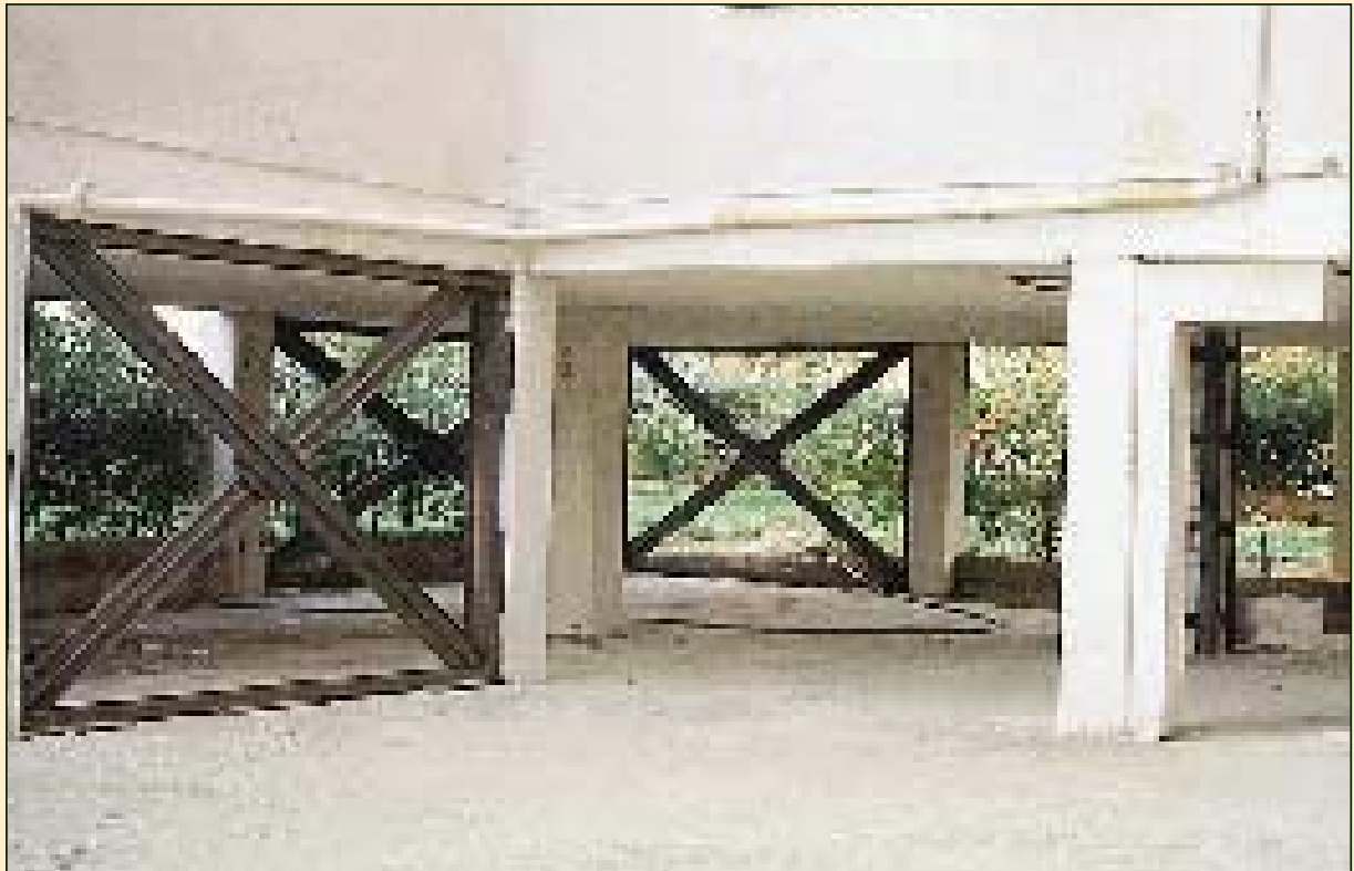
ΜΕΤΑΜΟΡΦΩΣΗ ΑΤΤΙΚΗΣ 1995 Εκτεταμένη υποσύλωση με σιδηρές διατομές (γωνιακά ισχυρά, διπλά ταύ, λάμες, χιαστί συνδέσμους κ.λπ.) σε τετράροφη οικοδομή με σοβαρές βλάβες στα υποστυλώματα της Pilotis
