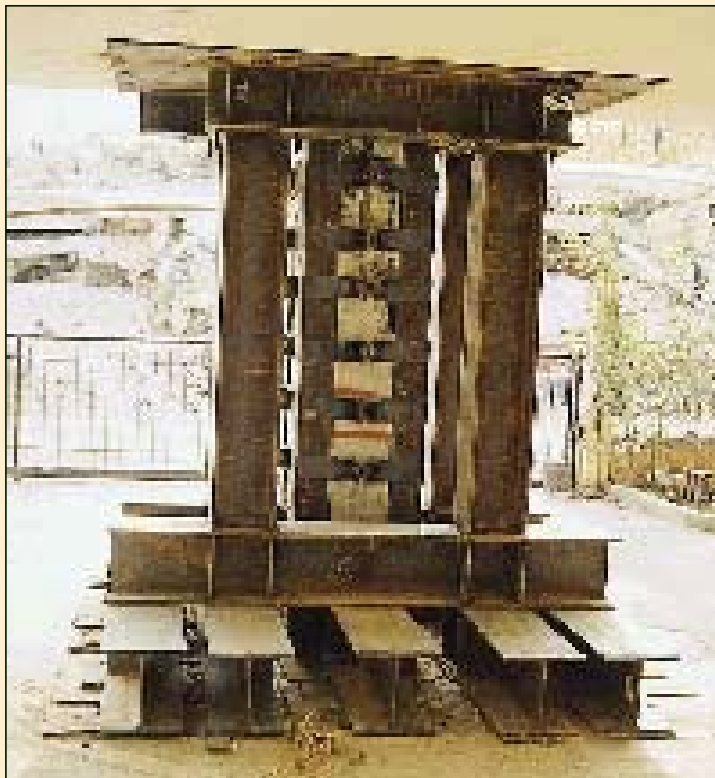
ΜΕΤΑΜΟΡΦΩΣΗ ΑΤΤΙΚΗΣ 1995 Εκτεταμένη υποσύλωση με σιδηρές διατομές (γωνιακά ισχυρά, διπλά ταύ, λάμες, χιαστί συνδέσμους κ.λπ.) σε τετράροφη οικοδομή με σοβαρές βλάβες στα υποστυλώματα της Pilotis
