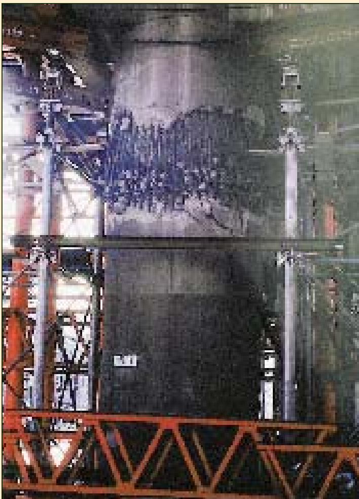
ΚΟΜΠΕ Ιαπωνίας 1995 Εκτεταμένες και βαρείες υποστυλώσεις με «πάσης φύσεως» σιδηρές διατομές, βαρέως τύπου σε μεγάλες γέφυρες της πόλης, που υπέστησαν σοβαρές βλάβες στα βάθρα τους και σε μήκος πολλών χιλιομέτρων.
