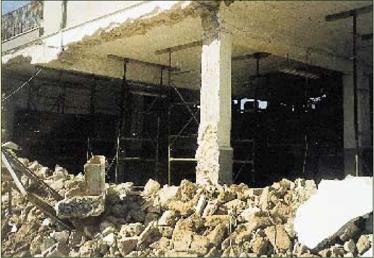
ΑΤΤΙΚΗ - ΑΝΩ ΛΙΟΣΙΑ - 1999 Υποσιλώσεις με βιομηχανικά ικριώματα, των οποίων έγινε ευρεία, αλλά όχι πάντοτε σωστή χρήση, στην περίπτωση του καταστροφικού σεισμού της Αττικής.
