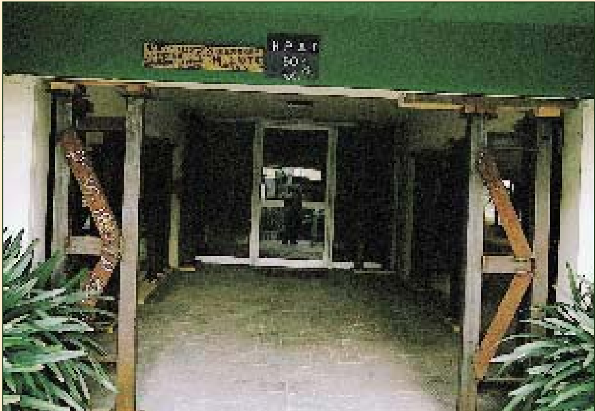
ΑΤΤΙΚΗ - ΝΕΟ ΗΡΑΚΛΕΙΟ - 1999 Εκτεταμένη υποσύλωση με κοιλοδοκούς σε Pilotis εξάρροφης οικοδομής, με σοβαρές βλάβες σε αρκετά από τα υποστυλώματά της
