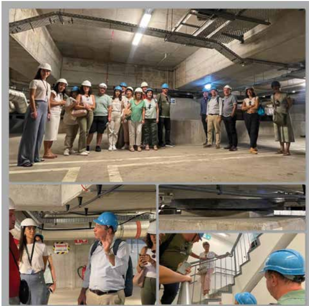
Εικ. 5, Τεχνική επίσκεψη στο Ίδρυμα Σταύρος Νιάρχος και στον χώρο των σεισμικών μονωτήρων, Σεπτέμβριος 2023
