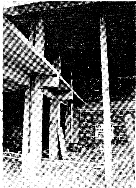
Σχ.17 Συνεργασία κοντῶν/συνήθων ὑποστυλωμάτων. Σφάγμα 3.5
