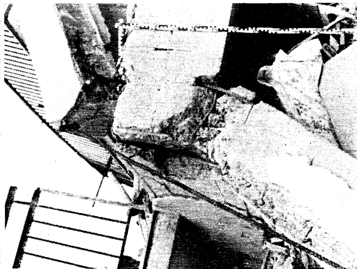
ΣΧ.2 Σεισμοί Καλαμάτας Σεπτ. 1986. Καλαμάτα. Πολυκατοικία Κολυμβητηρίου. Πλήρης άστοχία κόμβων δοκών-ίπποστρωμάτων.
