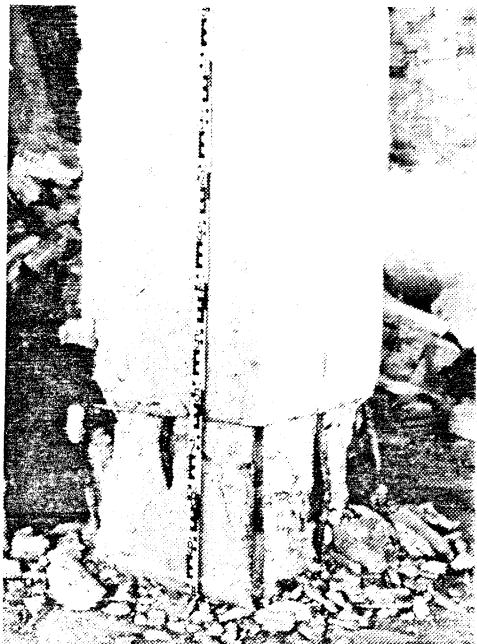
Σχ.29 Άνεπαρκείς συνδετήρες με ανεπαρκή άγκύρωση. Σφάλματα 3.1 καί 3.6. Συνδετήρες \phi 6/37 . Άγκύρωση συνδετήρα με 12\phi υπό γωνία 90^\circ (άντί 135^\circ )
