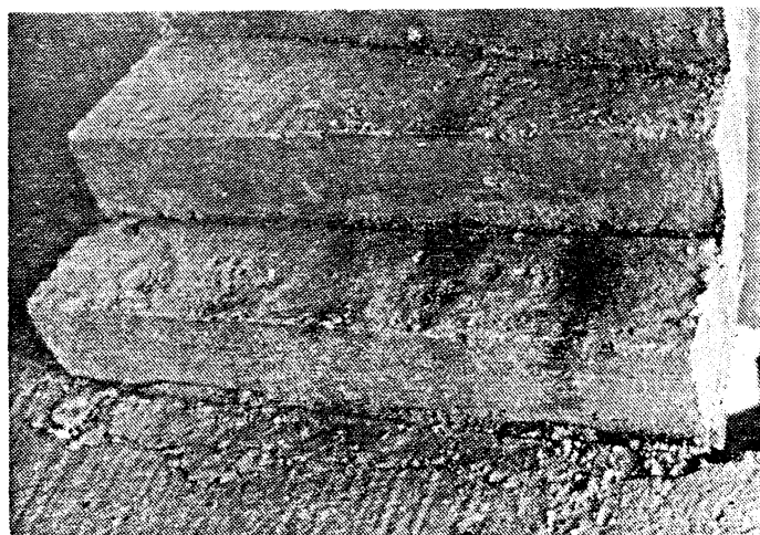
(6) Βλάβη στην γωνία \alpha < 180^\circ
