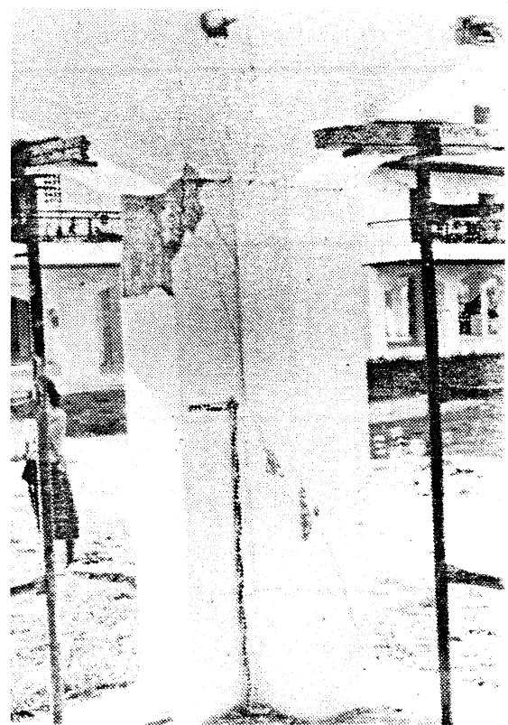
θ. ΔΣτ Ε1.Υ/ΥΜΝδ/2 (*Υποστύλωμα σύνηθες/διαξονική τέμνουσα μέ ροπή και άξονική/βαθμοῦ 2)
