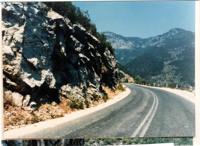
P50 Αποκόλληση βράχων ΧΘ 20.00 Δολομικός ασβεστόλιθος
