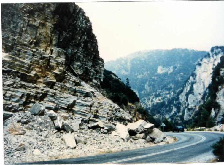
P65 Ολισθήσεις στον πλακώδη ασβεστόλιθο ΧΘ 40,70
