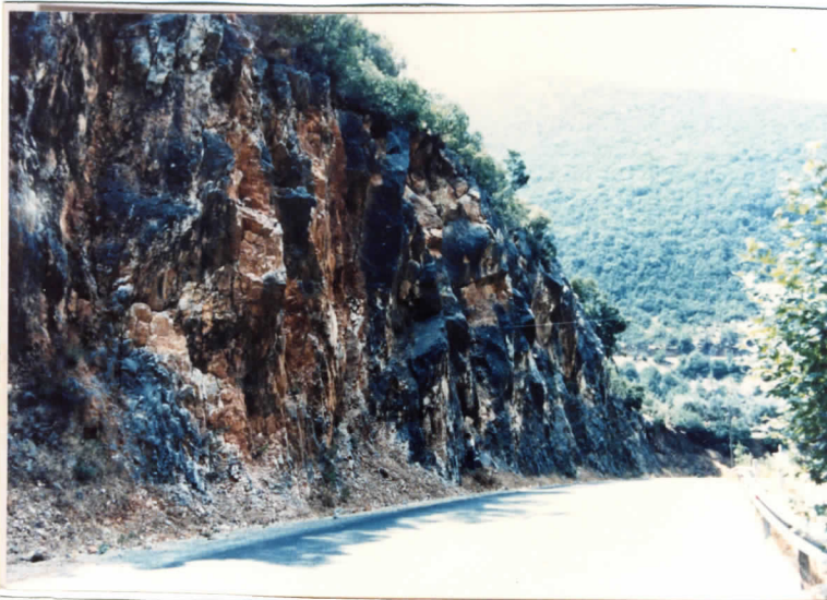
P24. Ασβεστόλιθος Τρίπολης. Διακλασμένος με σχεδόν κατακόρυφα συστήματα διακλάσεων τα οποία αποχωρίζουν μεγάλα τεμάχια του πετρώματος. Φαίνονται οι "ουλές" των αποκολλήσεων από τον σεισμό.
