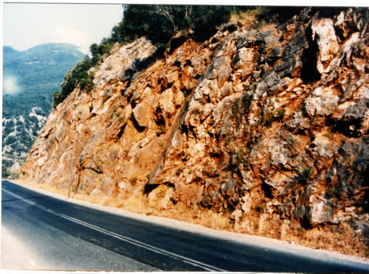
P22 Το ίδιο όπως το P21. Απαιτείται απομάκρυνση των επικίνδυνων βράχων
