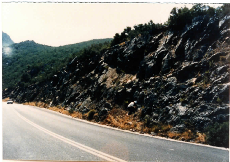
P13. ΧΘ 9.Ολίσθηση στον ασβεστόλιθο της Τρίπολης.
