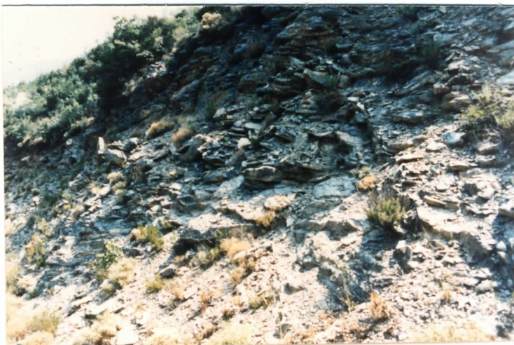
PK1. Δρόμος προς Καρβέλι. Σχιστοποιη- μένος ασβεστόλιθος και φυλλίτης. Ολισθήσεις κατά στρώση.
