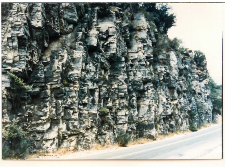
P61 ΧΘ 39. Πλακοειδής ασβεστίλιθος (Plattenkalk) πυκνοδιακλασμένος. Συνεχείς μικροκαταπτώσεις βράχων.
