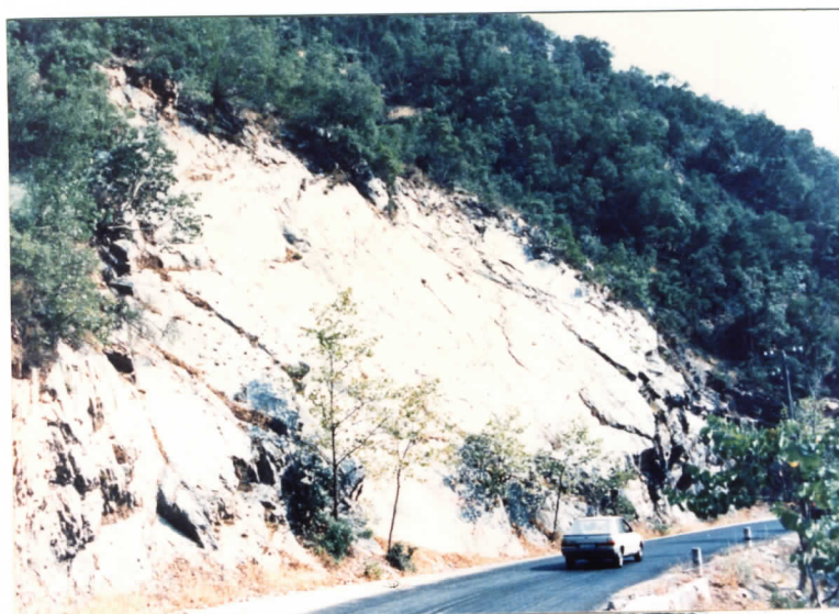
P28. Παλαιά ολίσθηση στη ΧΘ 15.70 διαστάσεων 30mX25mX3m.
