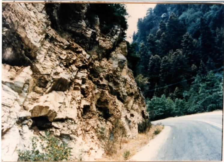
P62 Ανατροπές στον πλακώδη ασβεστίλιθο ΧΘ 40,50
