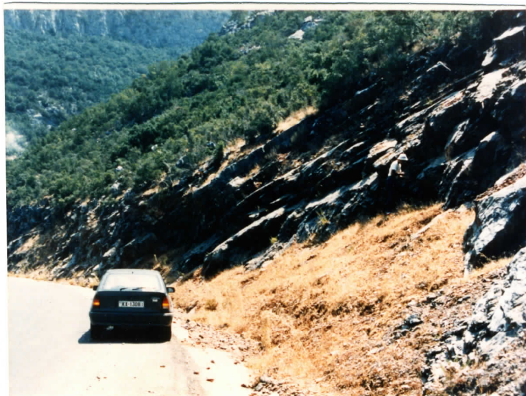
P15. ΧΘ 10,5.Μικροολισθήσεις πάνω στην στρώση του ασβεστόλιθου
