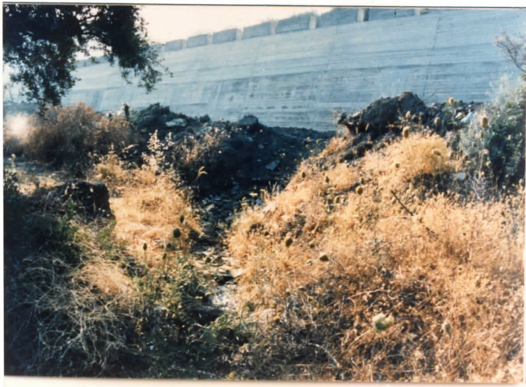
P7. Όπως και στην Ρ6. Διακρίνεται η έξοδος νερού από τη βάση του τοίχου τον Αύγουστο του 1988.
