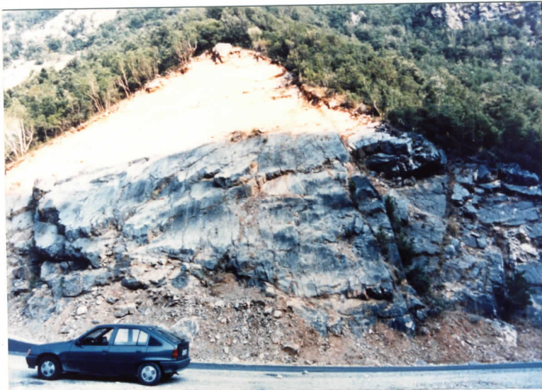
P29. Μεγάλη επίπεδη ολίσθηση στον ασβεστόλιθο Τρίπολης από τον σεισμό της 13/9/86. Διαστάσεις 25mX12mX1m
