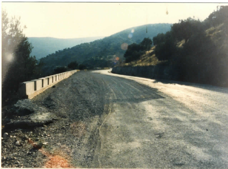
P6. Διόρθωση κατολίσθησης στο φλύσχη της Τρίπολης με τοίχο αντιστήρι- ξης.ΧΘ 7,00.
