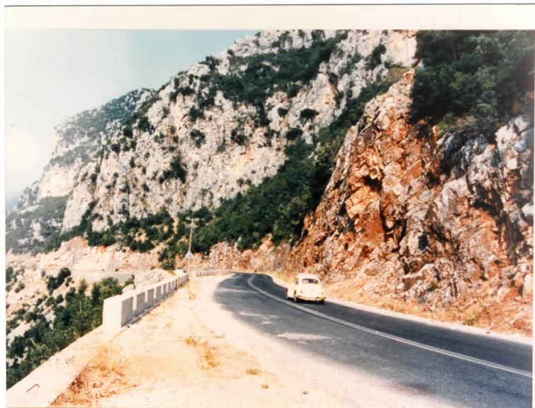
P18. Πυκνοδιακλασμένος ασβεστόλιθος Τρι- πολης. Συνεχείς καταπτώσεις βράχων διαφόρου μεγέθους.
