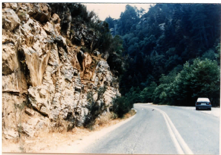
P62 Ανατροπές στον πλακώδη ασβεστίλιθο ΧΘ 40,50
