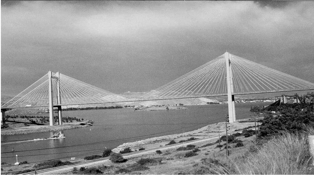
Σχήμα 6.4 Η Υψηλή Γέφυρα του Ευρίπου
