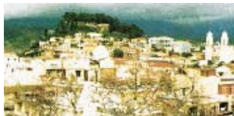
Η ΑΠΟΚΑΤΑΣΤΑΣΗ: Η περιοχή του Κάστρου της Καλαμάτας που είχε υποστεί τεράστιες ζημιές από το σεισμό, καλύτερη από πριν μετά την αποκατάστασή της.
