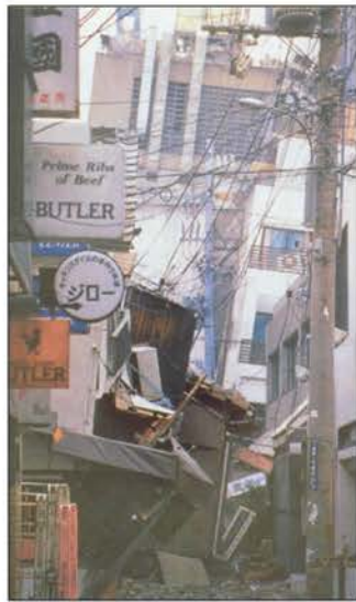
Στο κέντρο του Kobe της Ιαπωνίας κατά το σεισμό του 1994
