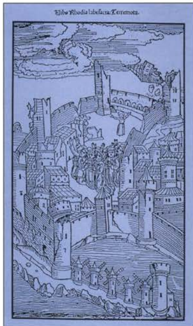
Ρόδος, σεισμός 3ης Μαΐου, 1481: Μεγάλες καταστροφές στην πόλη (ξυλόγλυπτο, 1496 στην Ulm, Γερμανία). (Πηγή: National Information Service for Earthquake Engineering, University of California, Berkeley, Kozak Collection, http://www.eerc.berkeley.edu/cgi-bin/kozak )
