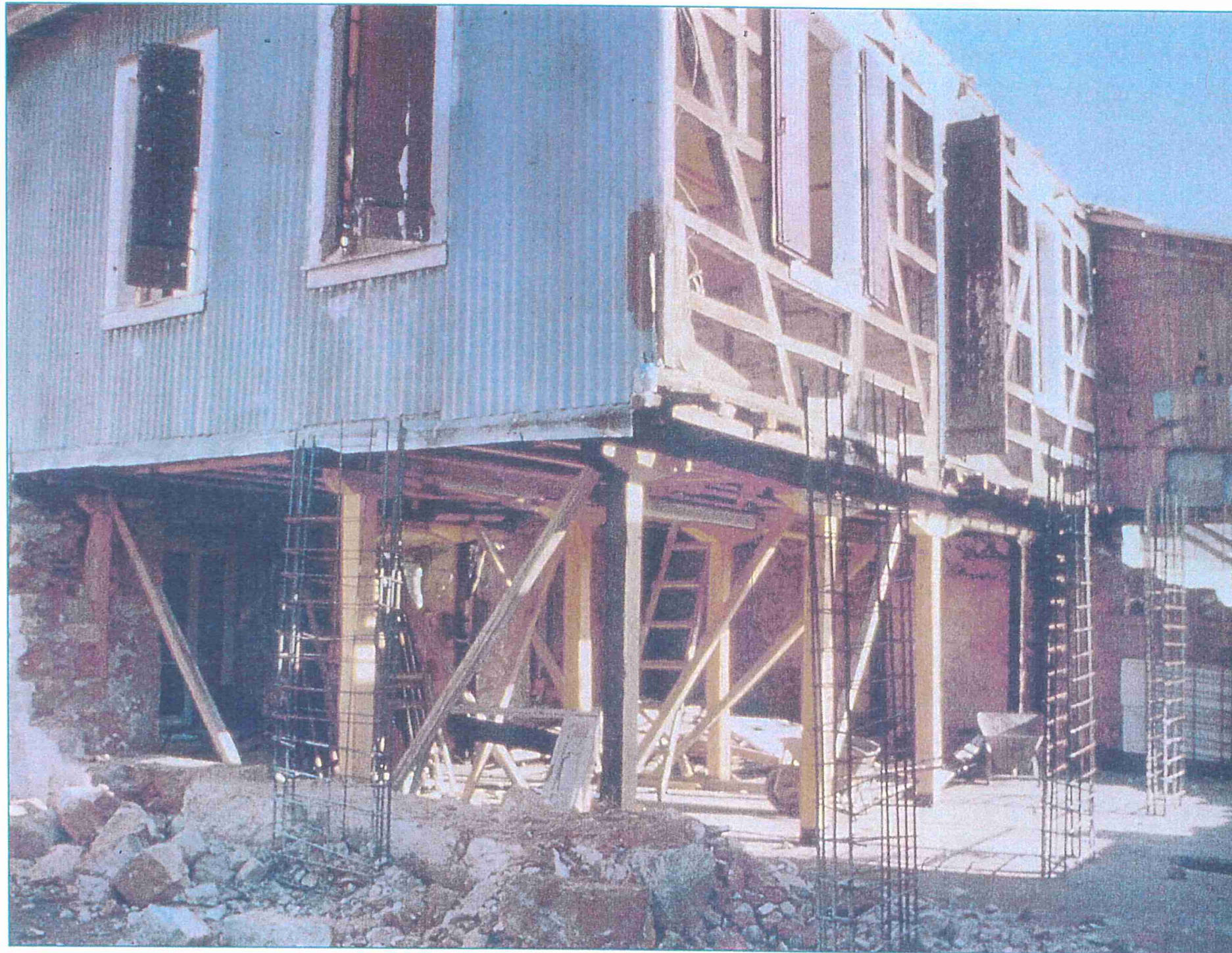
ΕΙΚ.8 Τυπικό κτίριο της Λευκάδας κατά την διάρκεια επισκευών και επεκτάσεων (πριν το 1995) στηριζόμενο προσωρινά στο βοηθητικό σύστημα ξύλινων υποστυλωμάτων στο ισόγειο.
