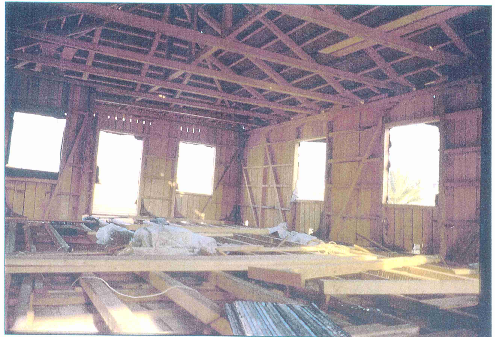
ΕΙΚ.24 Τυπικό παράδειγμα στήριξης των φορέων της στέγης στους ξυλόπηκτους, φεροντες τοίχους.
