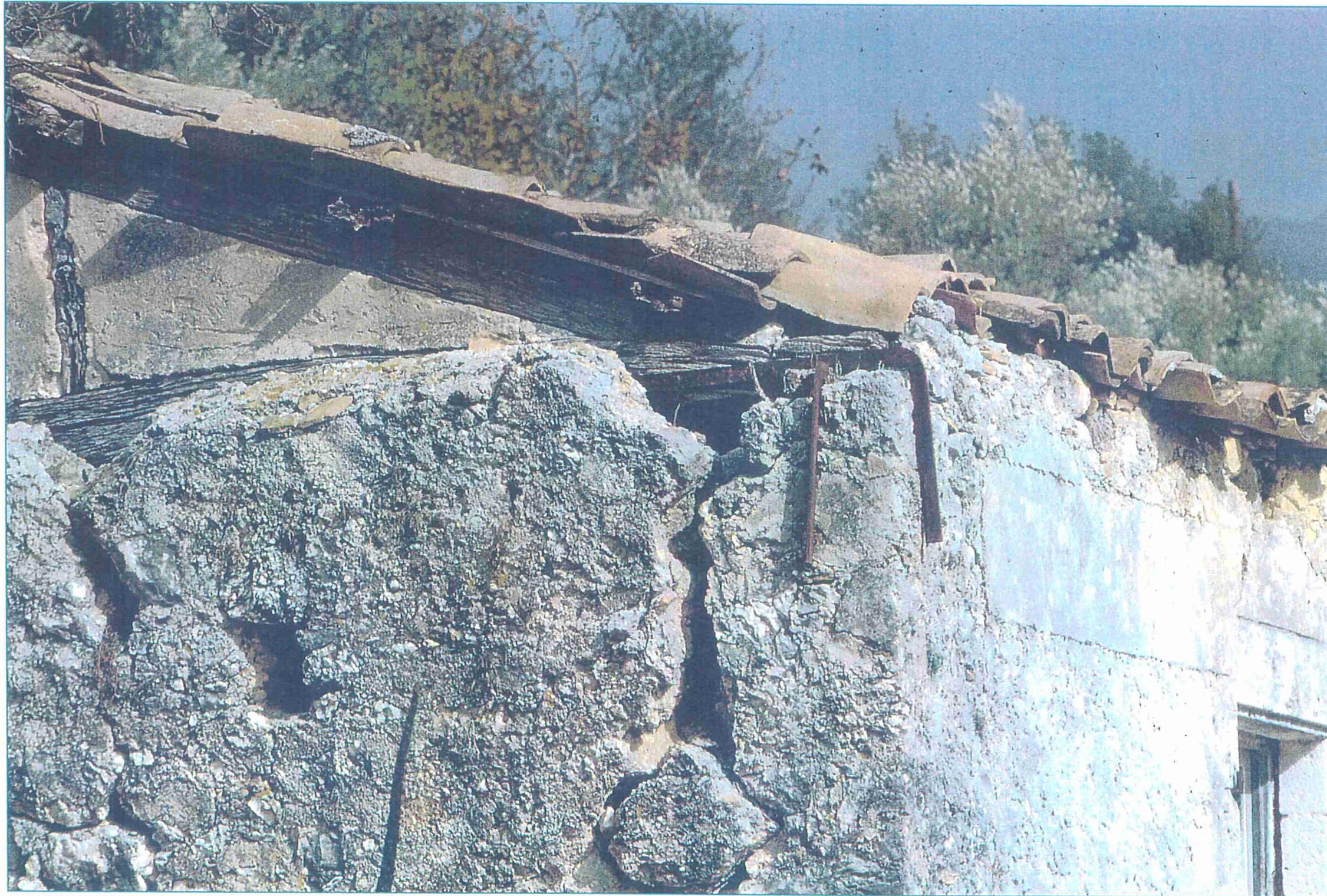
ΕΙΚ.4 Σιδηρά άγκιστρα συγκρατούν την ρηγματωμένη από τον σεισμό του 1953 λιθοδομή στον βοηθητικό ξύλινο φέροντα οργανισμό.
