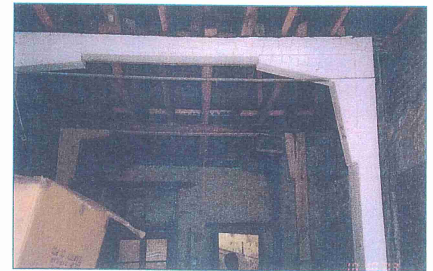
ΕΙΚ.9,10 Παραδείγματα ξύλινων πλαισίων που στηρίζουν τις δοκούς του πατώματος δίπλα στις φέρουσες λιθοδομές όσο και μεταξύ αυτών.
