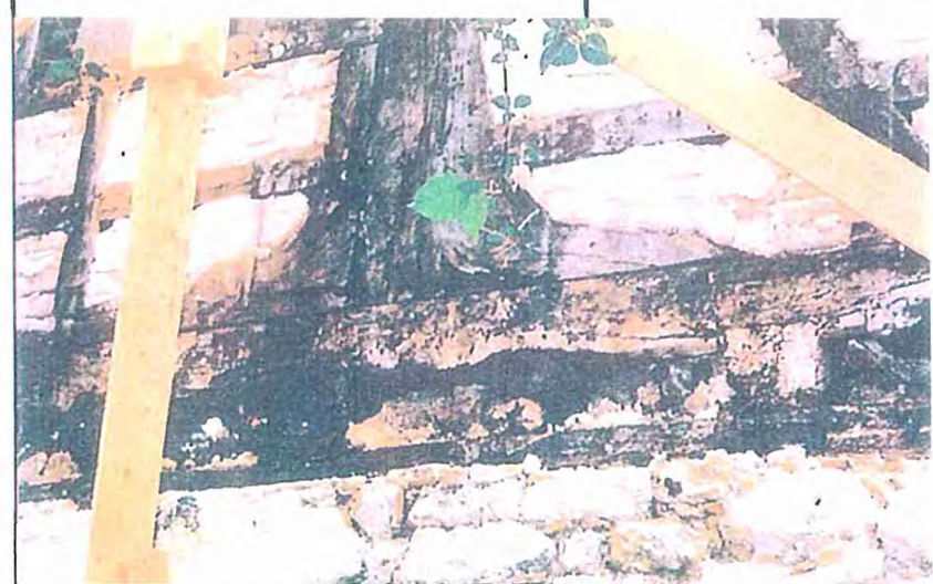
Εικ.2 Εμφάνιση σήψης και χλωρίδας σε διαβρεχόμενα ξύλινα στοιχεία.
