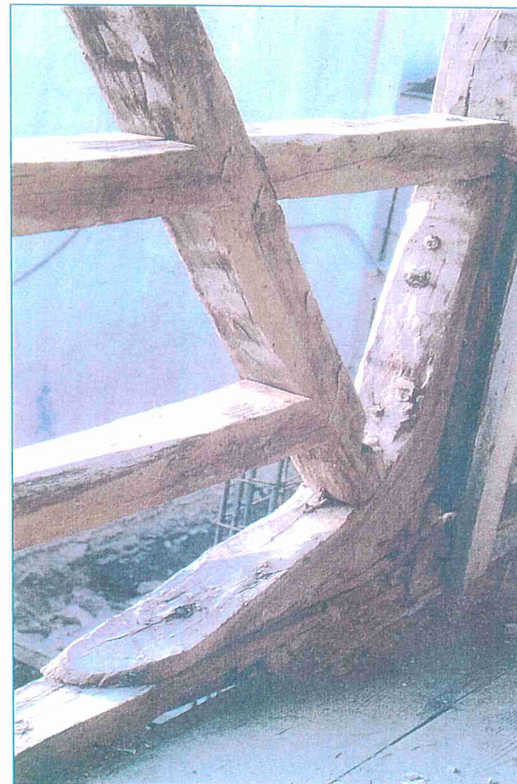
ΕΙΚ.15 Τυπικό παράδειγμα ενός “κανάβου” διαμόρφωσης του φέροντος οργανισμού των ξυλόπηκτων φερόντων τοίχων.
