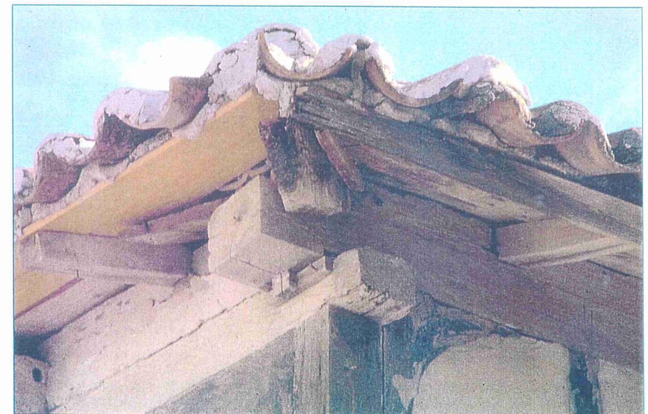
ΕΙΚ.26,27,28 Λεπτομέρειες διασταύρωσης των δοκών που είναι επί κεφαλής των περιμετρικών τοίχων στη γωνία του κτιρίου κάτω από την στέγη.
